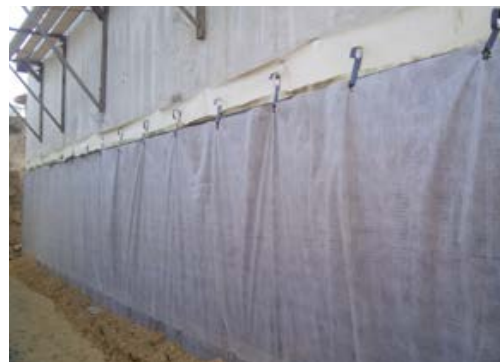
Пристенный дренаж и защита гидроизоляции
